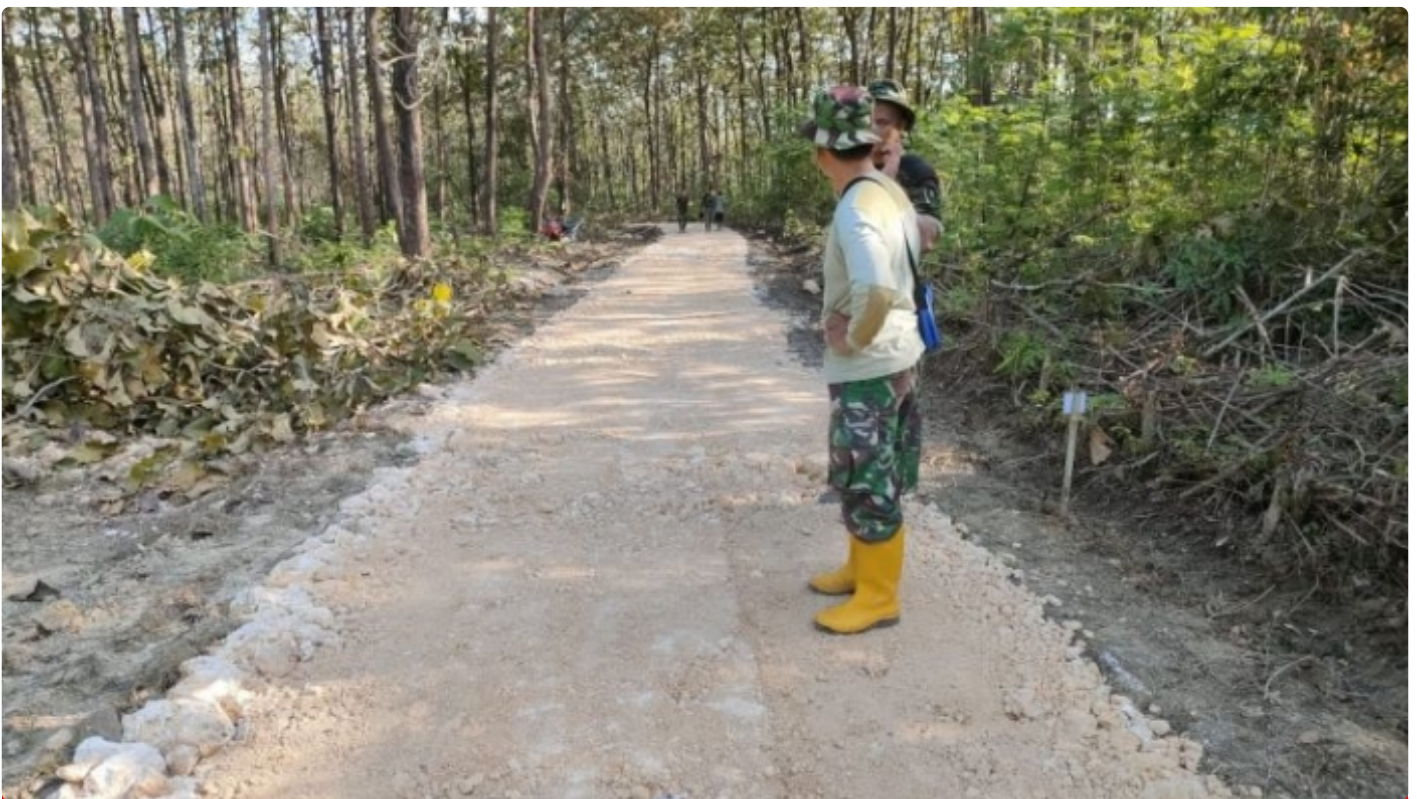
TMMD Reguler ke-113 Kodim 0721/Blora, di Desa Pengkoljagong, Kecamatan Jati, Kabupaten Blora
